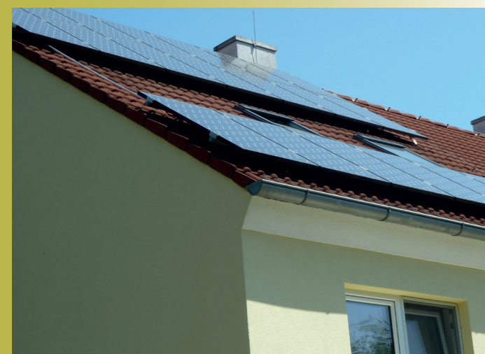
21 Module nach Süden ausgerichtet liefern an sonnigen Tagen bis zu 33 kWh Strom.
